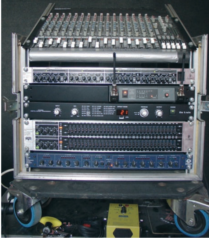
Bislang verrichtete im Proberaum dieses Rack seinen Dienst, das wegen dringender „Wartungsarbeiten“ vom „Xenyx X-1622“ ersetzt werden sollte
