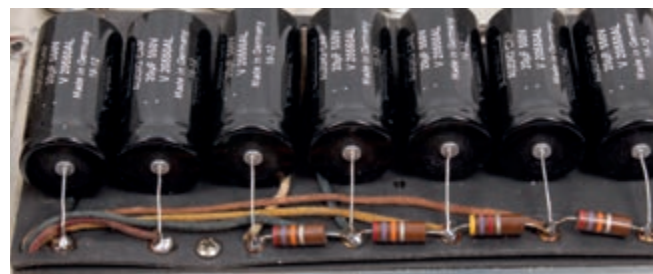
Netzteil Sieb-Elkos (Filter Caps) erneuert
